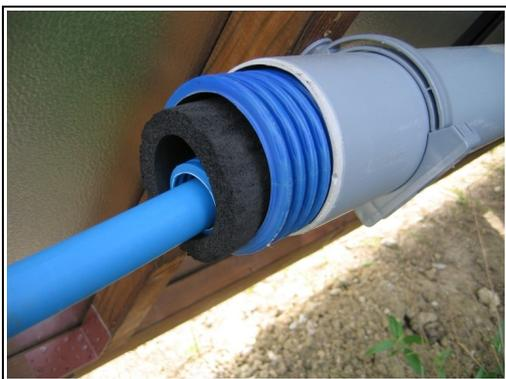
◀ Le retour capteur en PER gainé, isolé, gainé extérieur et supporté par la descente de gouttière (pour garantir la pente du drainback)
