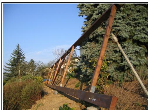
Le bâti qui supporte les capteurs a été construit en bois traité, fixé sur des piliers béton armé, eux même construits sur des fondations béton. L'orientation est de 10° Est et l'inclinaison de 60°. Une pente de 1% a été respectée pour la vidange du drainback.
