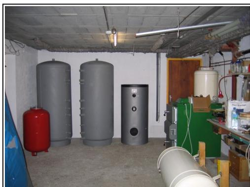
◀ Livraison du matériel, les ballons chauffage, le ballon ECS, la chaudière bois, le vase d'expansion et un vieux ballon ECS (couché), qui servira de réservoir drainback.
