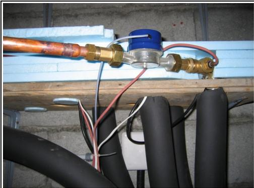
◀ Vannes 3 voies et départs échangeurs
