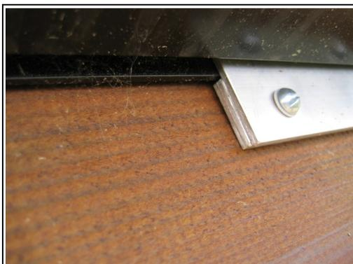
◀ Fixation du bas des capteurs (avec isolation galvanique)
