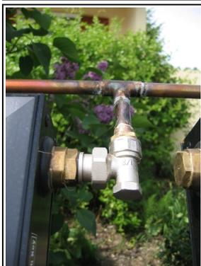
◀ Robinet de réglage de radiateur pour l'équilibrage capteurs
