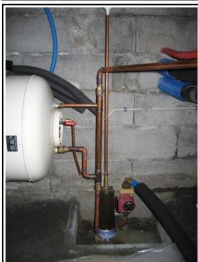
◀ Le départ aux capteurs (dans la cave), le circulateur solaire, le séparateur d'air, le réservoir drainback.
